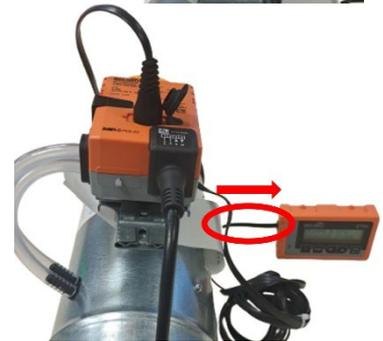
5. Ziehen Sie das Kabel ab, sobald die Einstellung abgeschlossen ist.
