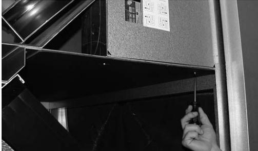
Das Motorkabel demontieren; dabei die Position der Leitungen in der Klemmreihe notieren.
