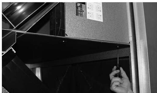
Die Box mit dem Frequenzwandler montieren und mit Schrauben befestigen.
