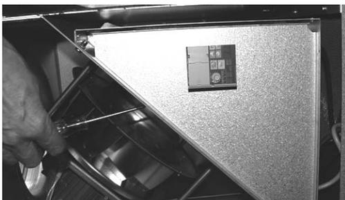
Die Box mit dem Frequenzwandler montieren und mit Schrauben befestigen.
