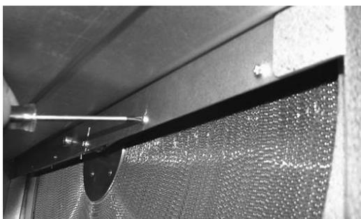
Den vorderen Winkel mit der Dichtleiste an der Wartungstür-Seite demontieren
