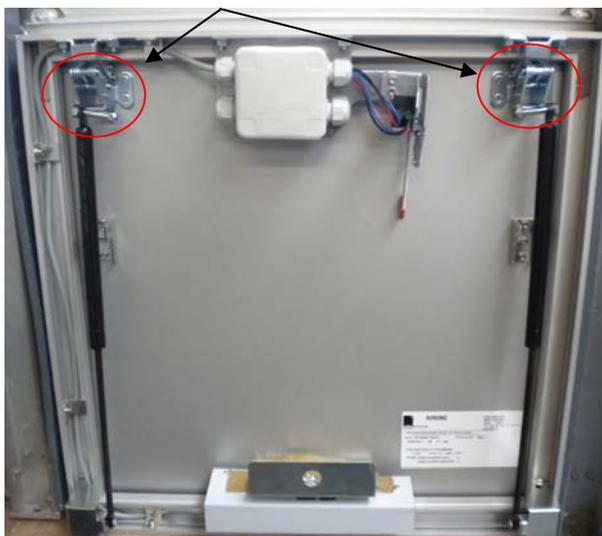
2/ Ouvrir l'appareil, puis boulonner les 2 ressorts à gaz sur les chapes du panneau.
