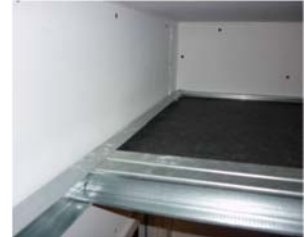
Figure 2 – Réseau de distribution par "plenums"
