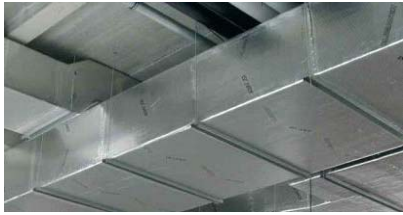
Figure 1 – Réseau de distribution par "conduits isolés"
