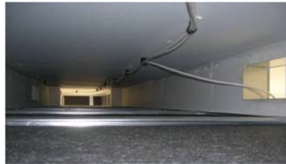
Figure 2 – Réseau de distribution par "plenums"
