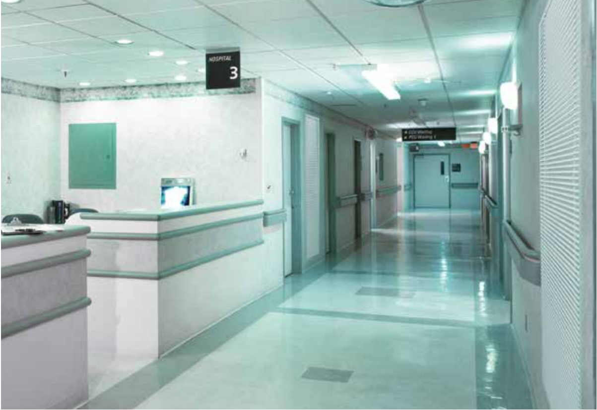
Grille de désenfumage en milieu hospitalier
