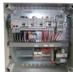
Coffret de désenfumage parking
