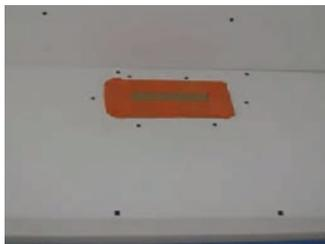
A la fin de la réalisation du plénum, obturation des découpes des bouches motorisées pour éviter l'accumulation de poussière à l'intérieur du plénum pendant la suite du chantier
