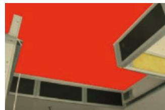
Cas maison à étage ou collectif : mise en œuvre isolant en sous face supérieur du plénum (polystyrène extrudé de 20 mm)
