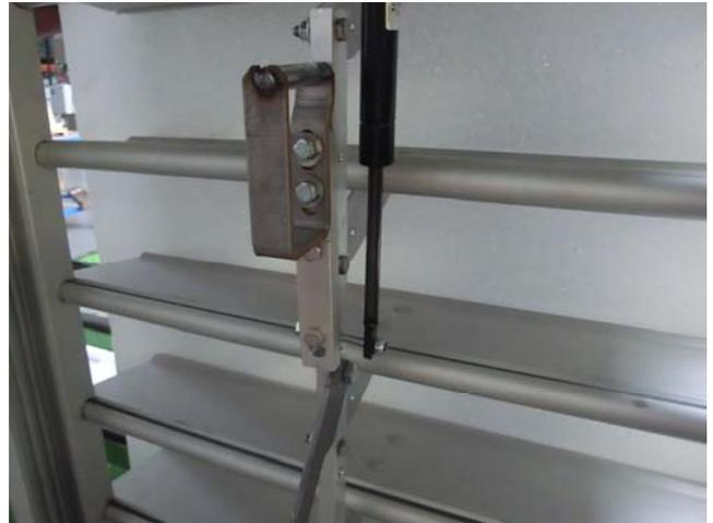
OXYTONE LAMES 2013 en position de sécurité (ouvert), démonter le levier de réarmement manuel et le système « gâche ».
