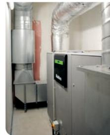
“Dans le cadre du lot CVC qui nous a été confié, nous avons en effet la responsabilité de mettre en œuvre la nouvelle centrale double flux Everest ainsi que deux hottes d'extraction Hozone au-dessus du four et de la laverie avec compensation d'air T.VEC Silence et un caisson en ligne Vekita + (pour VMC sanitaire, bureau).
