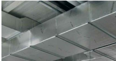
Figure 1 – Réseau de distribution par "conduits isolés"
