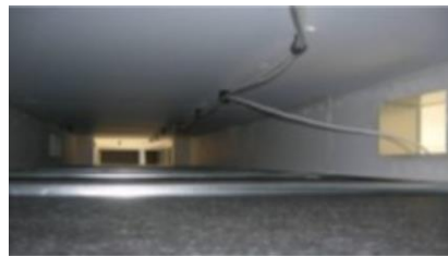
Figure 2 – Réseau de distribution par "plenums"
