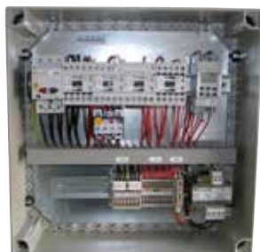
Coffret de désenfumage habitat collectif
