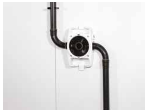
Berceau mural avec raccordement aéraulique diamètre 44 mm
