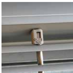
Clip de verrouillage sur OPTONE® «+grille»
