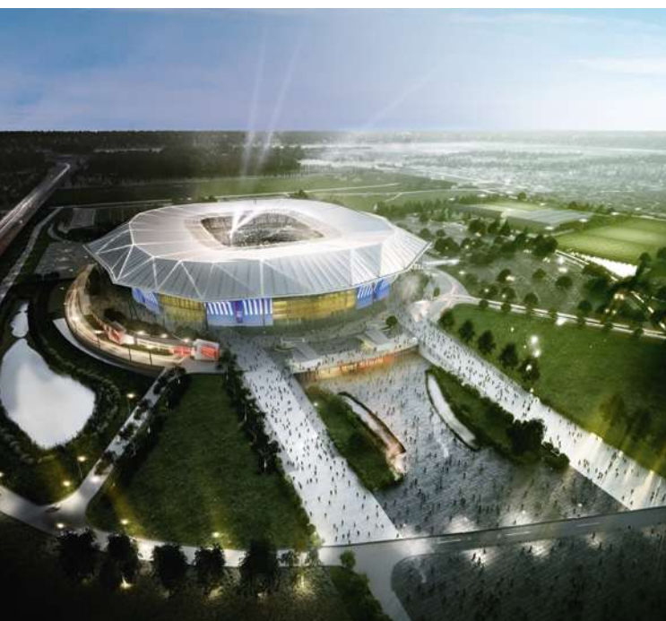
Chantier : stade Olympique Lyonnais - Décines
